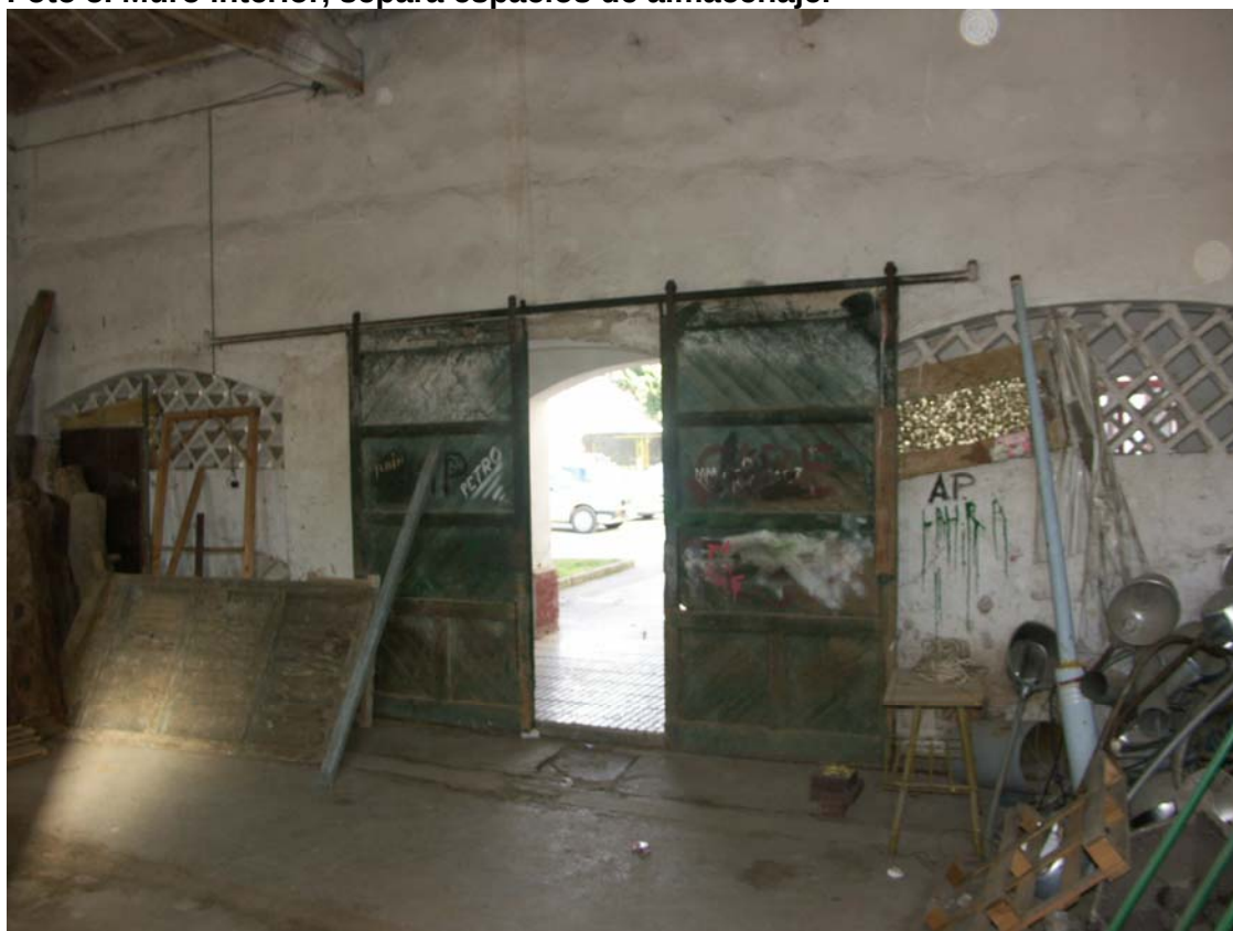
Foto 6. Entrada a espacio sur de almacenamiento.
