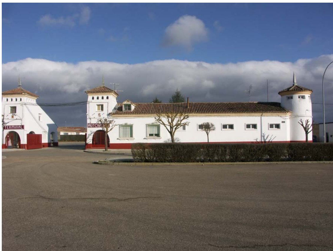
Foto 3. Fachada oeste a Avenida Eusebio Salvador.
