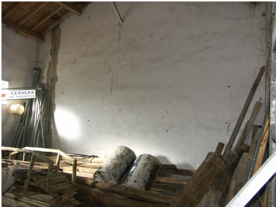
Foto 5. Muro interior, separa espacios de almacenaje.
