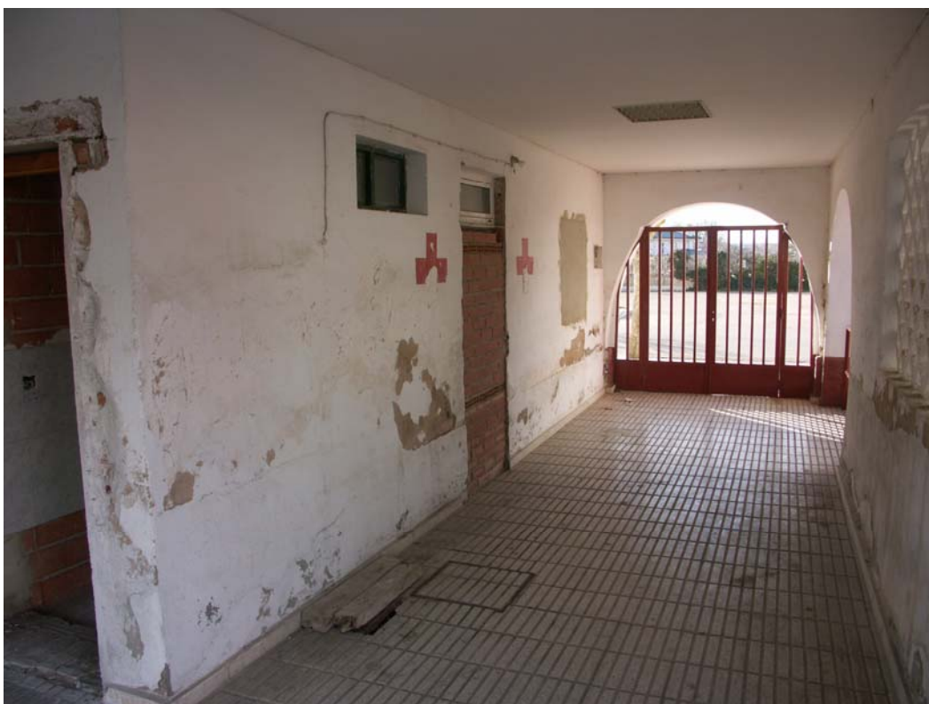
Foto 8. Vista de porche norte.
