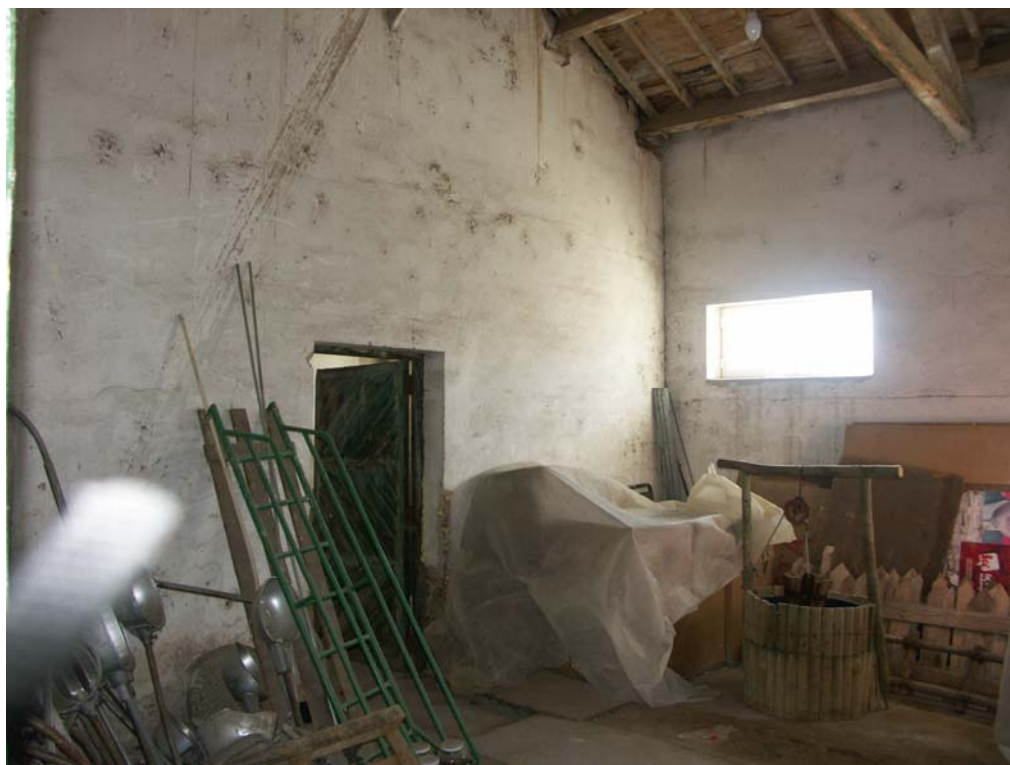
Foto 4. Fachada medianera sur.
