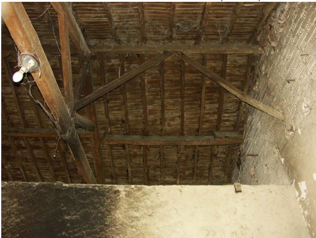
Foto 7. Vista interior de espacio intermedio de nave.
