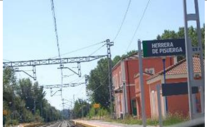
Estación de Ferrocarril de Herrera de Pisuerga
