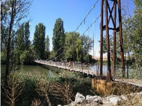
Pasarela sobre el río Pisuerga -Centro de interpretación del Canal de Castilla
