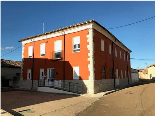
Sustitución de carpinterías, reparación de fachadas y repintado, colocación de vierteaguas, rebaje de acera e instalación de nuevos radiadores. El presupuesto total es de 21.410,00 €. En el año 2.018 se habían invertido ya 7.908,68 € y en el año 2019 el resto con un total de 13,508,32 €
